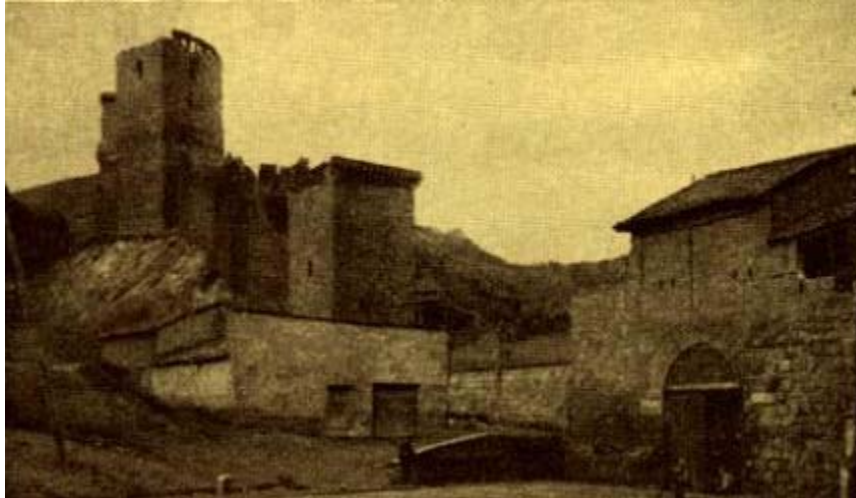
Puerta Alta y Murallas
